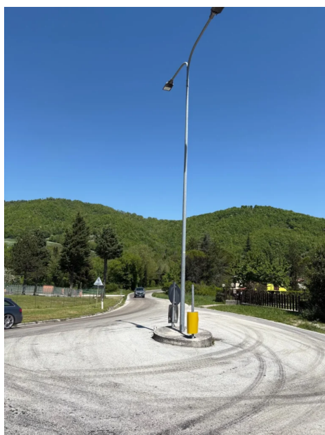
Sarnano - Nuovo impianto strada Sassotetto
