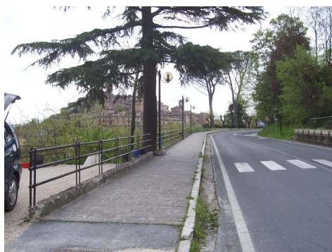
Sarnano - Vecchio impianto Ingresso Città
